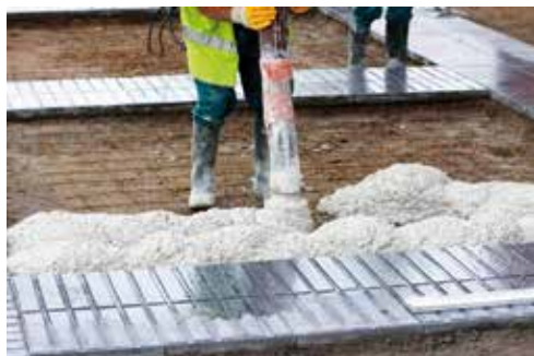
Fot. 4. Wbudowanie mieszanki betonowej
