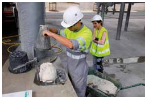
Fot. 2. Kontrola produkcji mieszanki betonowej
