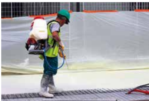
Fot. 6. Rozpylanie dezaktywatora
