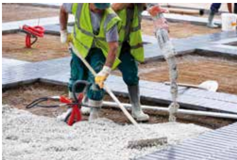
Fot. 5. Rozprowadzanie mieszanki
