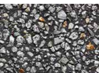
Fot. 13. Powierzchnia wypłukana na kruszywie 2–16 mm (grys granitowy), czarne zabarwienie zaprawy
