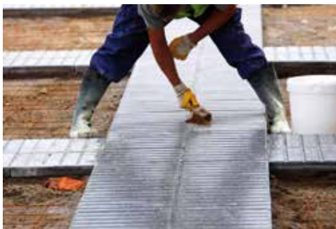
Fot. 3. Zabezpieczanie powierzchni pomocniczych
