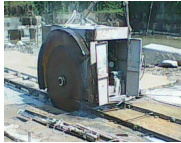
Fig. 8. Disc sawing machine operation at Chu Que dimension stone quarry in Thua Thien Hue Province of Vietnam Rys. 8. Piła tarczowa w kamieniołomie Chu Que w prowincji Thua Thien Hue w Wietnamie
