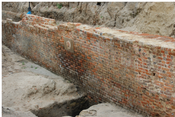
Il. 1. Widok kurtyny muru wschodniego z otworem strzelniczym o wykroju kolistym z fazy I zamurowanym w fazie II (fot. R. Mrućzek)
