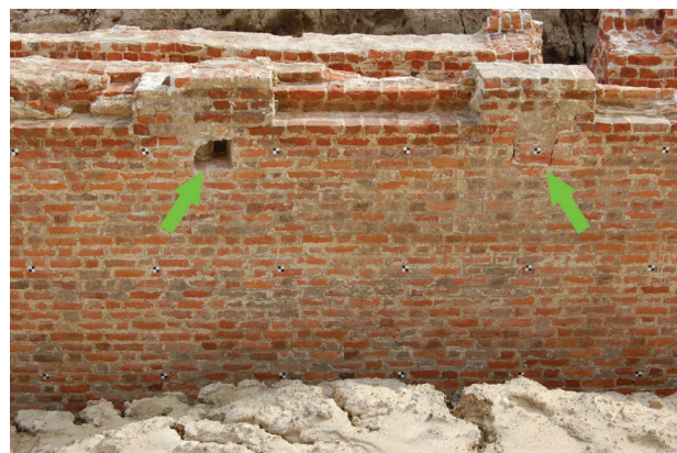
Il. 3. Filarki osadzone w otworach w miejscu wcześniejszych drewnianych sęczeń (fot. R. Mruczek)
