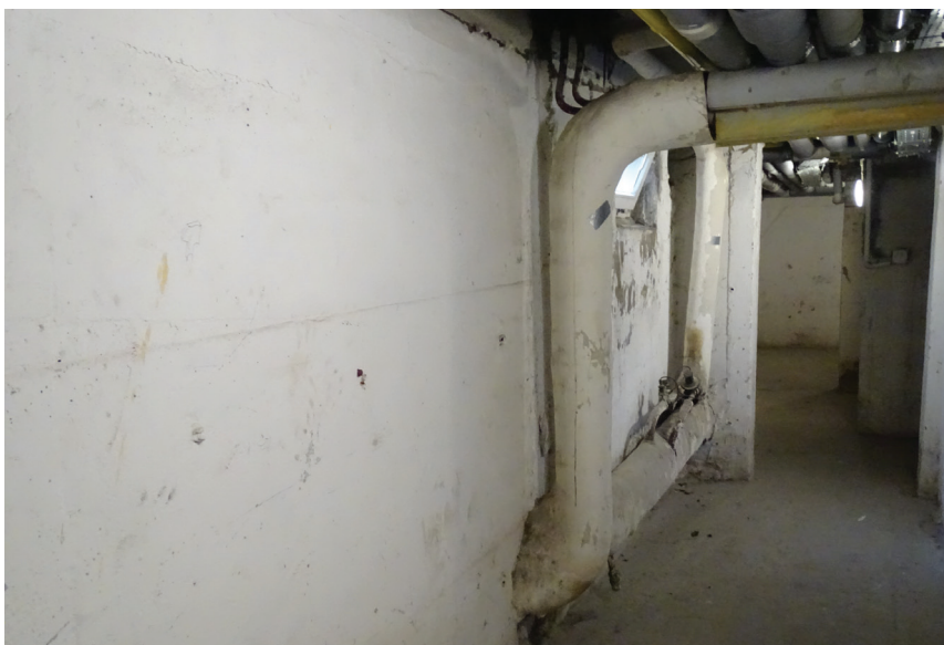
Rys. 5. Typowy korytarz piwniczny w budynku wielkopłytkowym (Warszawa 2016)
