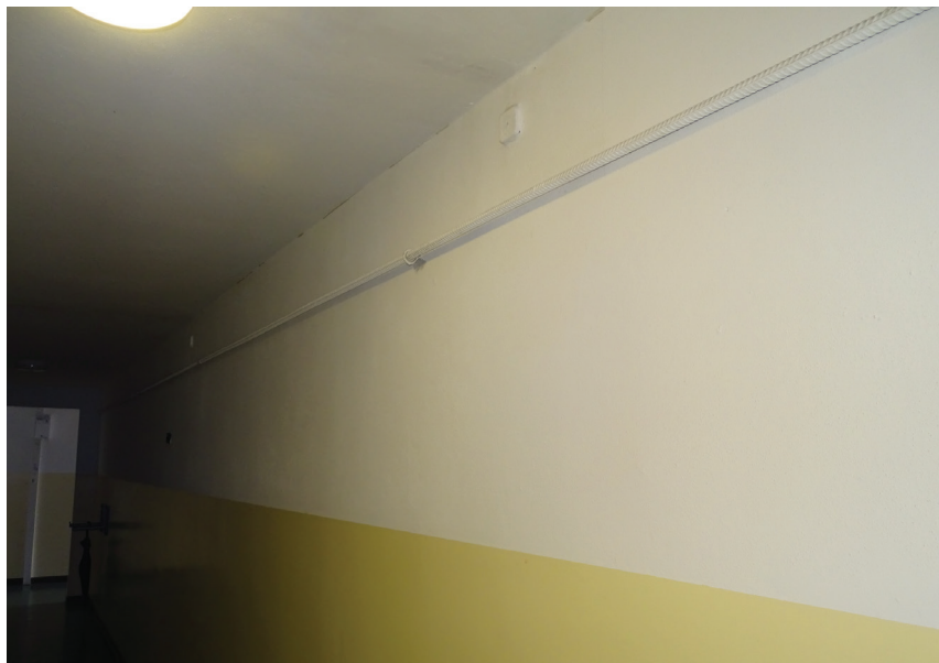
Rys. 8. Korytarz na wzmocnionej kondygnacji, widoczny pręt ściągu (Warszawa 2016)
