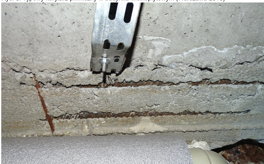
Rys. 6. Odkryte zbrojenie części monolitycznej w korytarzu piwnicznym (Warszawa 2016)
