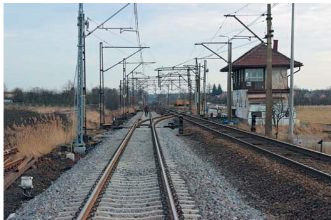
Fot. 4. Prace na stacji Koszęcin na odcinku Kalety–Kluczbork (13.01.2014 r.)
