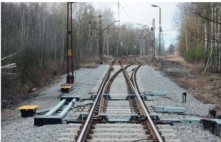
Fot. 6. Wymieniony w ramach projektu „rozjazdowego” rozjazd typu 60E1-500-1:12 na stacji Sośnie Ostrowskie na linii Ostrów Wielkopolski–Grabowo Wielkie
