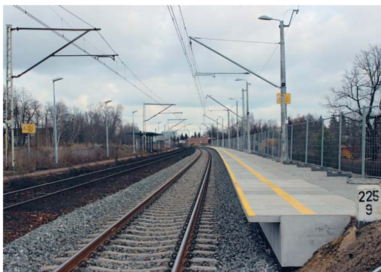
Fot. 2. Peron przy torze nr 2 na odcinku linii nr 1 Kolaszki–Częstochowa (13.01.2014 r.)
