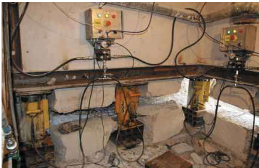
Rys. 8. Zestaw podnośników podnoszących budynek Rys. 8. Set of jacks raising the building
