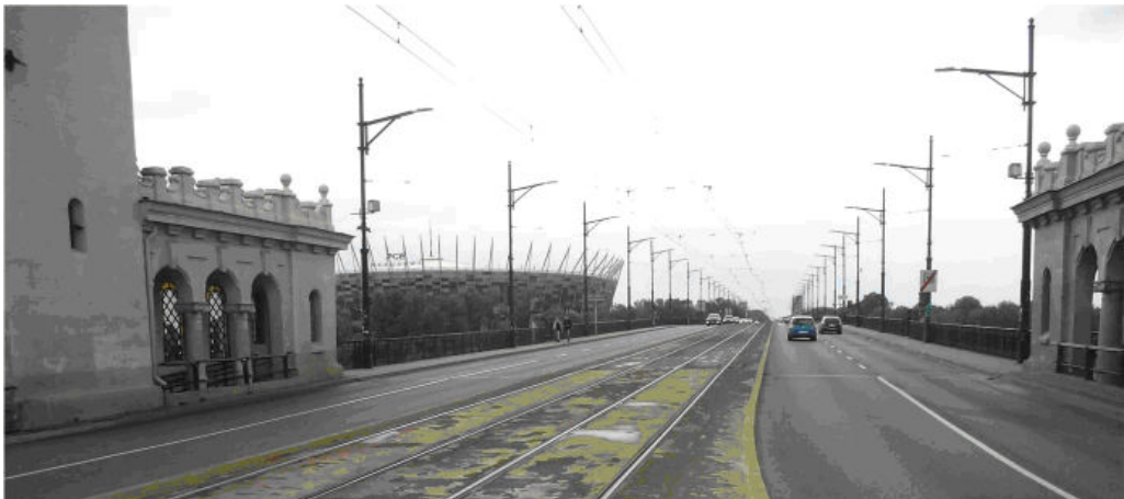
Rysunek 5. Most księcia J. Poniatowskiego w Warszawie nie zawiera żadnej konstrukcji chroniącej strefę ruchu pieszego (podobnie jak most Powstańców Śląskich w Krakowie) (fot. autora)
