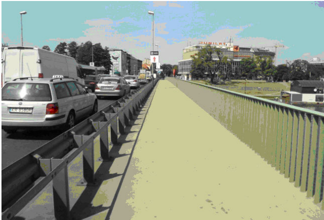
Rysunek 3. Most Dębnicki w Krakowie – bariery energochłonne oddzielające jezdnię od strefy pieszej (fot. autora)
