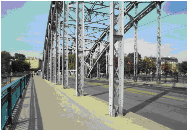
Rysunek 4. Most J. Piłsudskiego w Krakowie – elementy pionowe konstrukcji mostu nie spełniają funkcji całkowitej separacji ruchu pieszego i kołowego (fot. autora)
