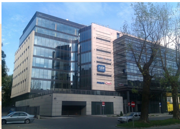
Zdjęcie.1. Budynek Sterlinga Business Center w Łodzi.
