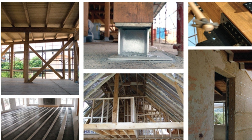
Zdjęcie 4. Dokumentacja fotograficzna z budowy KeoHabitat.
