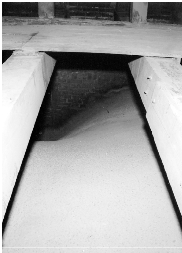
Fot. 33. Fragment sklepienia po zakończeniu prac
