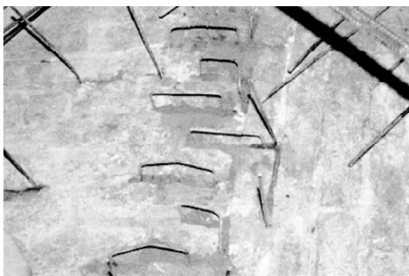
Fot. 18. Strzemiona wklejone w sklepienie w miejscu ukrytego żebra
