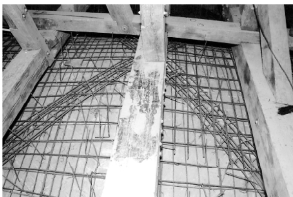
Fot. 19. Układanie pierwszej warstwy zbrojenia. Widoczne zbrojenie ukrytych żeber
