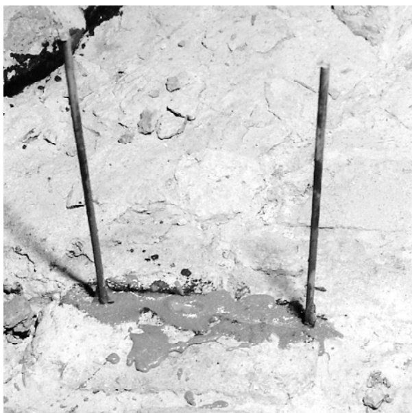
Fot. 15. Kotwa po zalaniu żywicą
