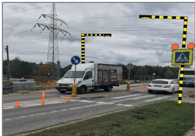
Rys. 13. Schemat proponowanych zmian poprawy widoczności w obrębie przejścia dla pieszych na ul. Kartuskiej Źródło: opracowanie własne
