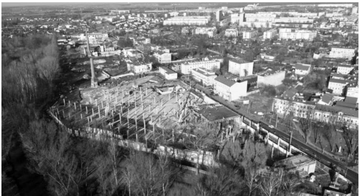
Ryc. 11. Budowa nowej galerii handlowej przy ul. Barlickiego, rok 2016; źródło: http://tomaszowmazowiecki.naszemiasto.pl/artykul/zdjecia/budowa-galerii-tomaszow-uroczystosc-wmurowana-ka-mienia,3645744,artgal,18975596,t,id,tm,zid.html (dostęp: 01.08.2017)
