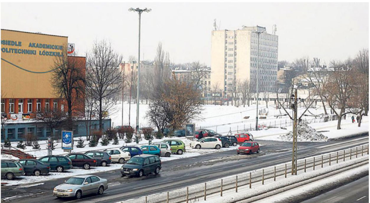
Ryc. 7. Stan z 2009 roku, po wyburzeniu obiektów „Malteku” – widok od strony południowo-wschodniej; źródło: http://lodz.naszemiasto.pl/artukul/przy-alei-politechniki-postanie-nowa-galeria-handlowa,314616,artgal,t,id,tm.html (dostęp: 01.08.2017)
