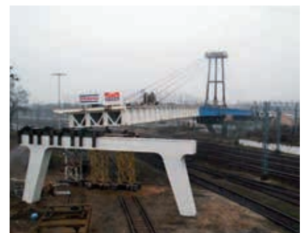
Ryc. 2. Nasuwanie konstrukcji nad czynnymi torami kolejowymi
