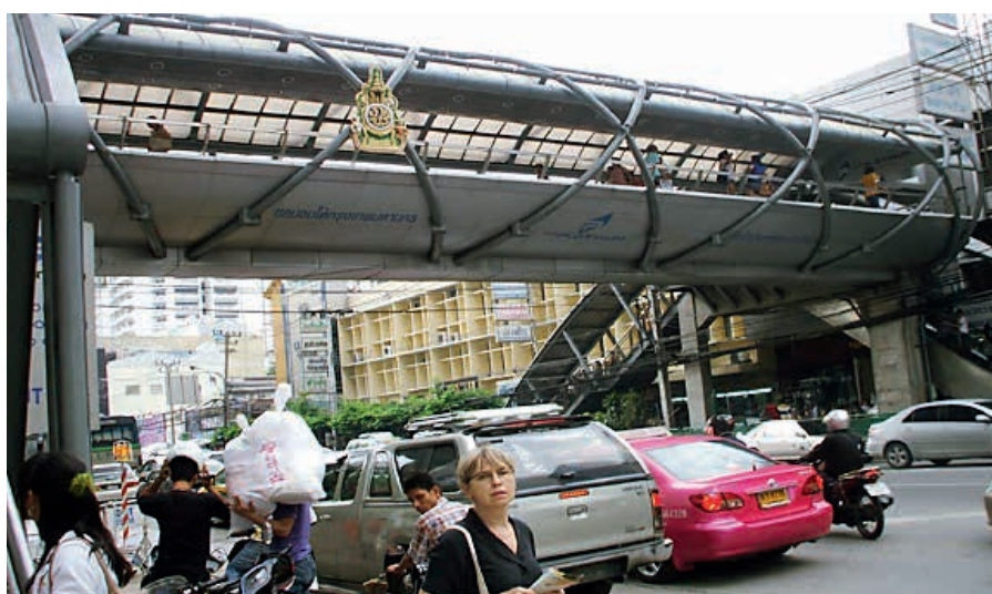
Ryc. 4. Kładka dla pieszych w gęstej zabudowie miejskiej
