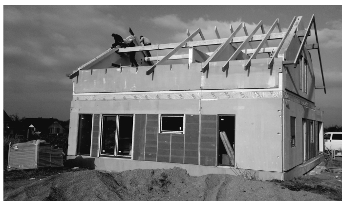
Rys. 1. Wznoszenie domu mieszkalnego w konstrukcji szkieletowej [7]
