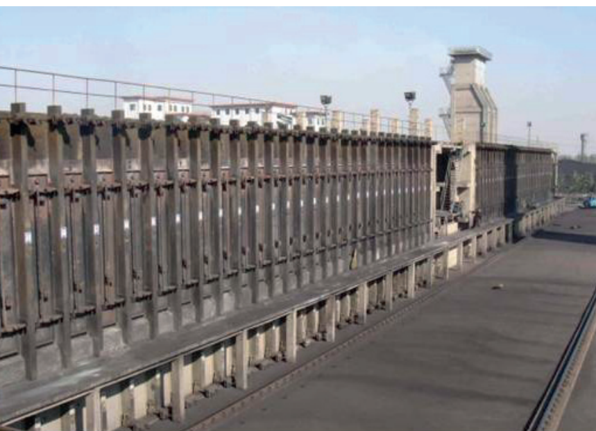
Rys. 10. Widok baterii koksowniczej dwuproduktowej z pionowymi komorami
