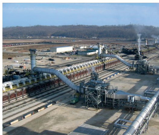
Rys. 4. Zdjęcie baterii dwuproduktowej pracującej w wersji z odprowadzeniem spalin poprzez parowy kolektor odzyskicowy umieszczony ponad piecami (źródło SunCoke Energy).
