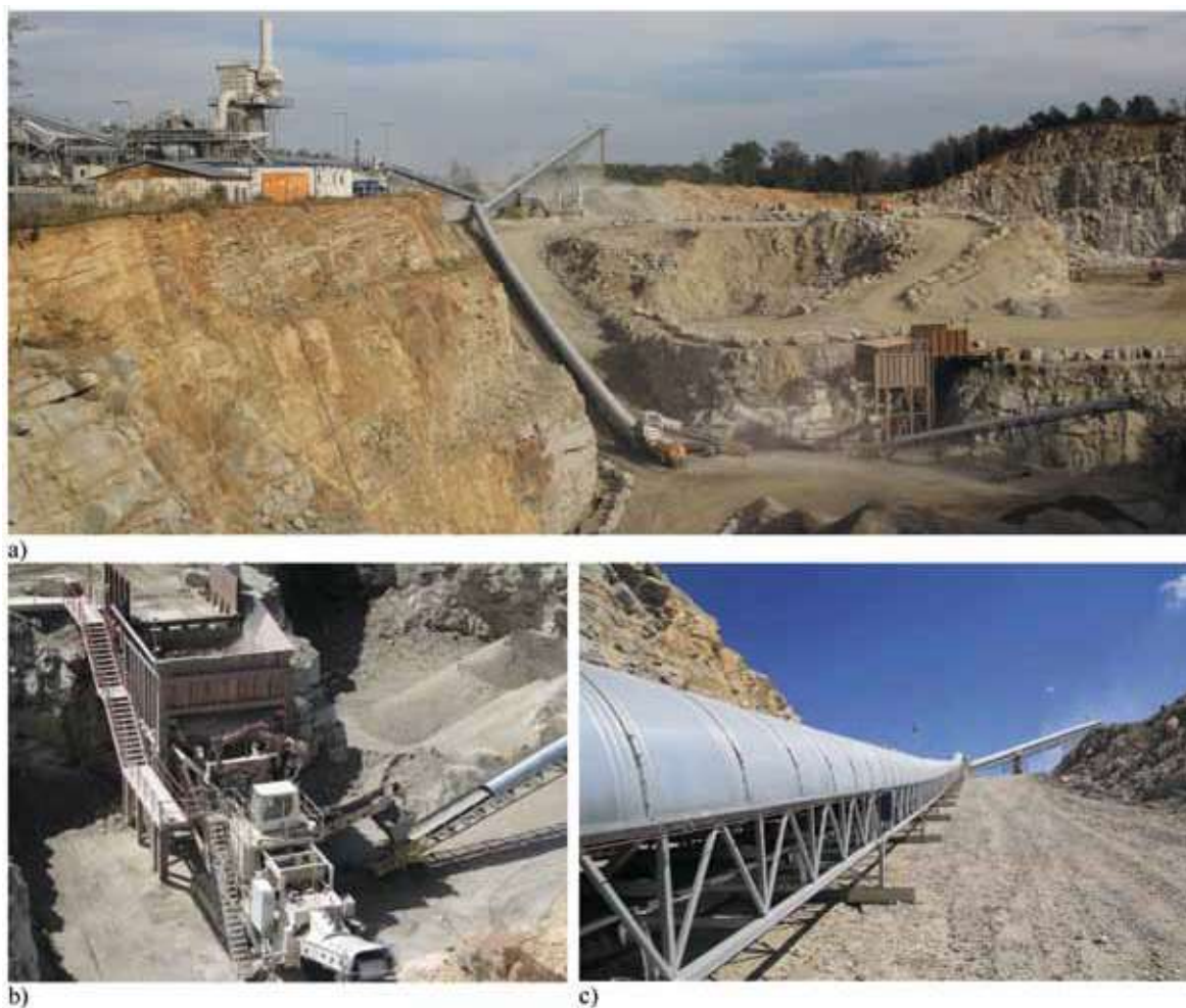
Rys. 6. Instalacje w Kopalni Wieńnica w układach K–S–WLT–PT–ZT–ZP: a) wyrobisko z układem wydobywczym i przeróbczym, b) przestawny węzeł zasypowy z kruszarnią LT 140, c) przestawny przenośnik trasowy PT1 200/170 oraz składujący PT 1200/68 (fot. M Stefanicka, T. Wojtaszek)
