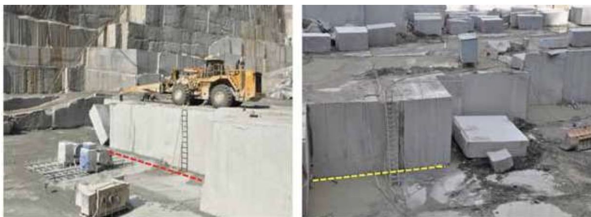
Rys. 14. Innowacyjne urabianie monolitów piłą linową: a) zmodyfikowana metoda fińska, płaszczyzna pozioma wykonana strzelaniem LT (kolor czerwony), b) metoda z „odsunięciem” – monolit wycięty z górotworu piłą linową (cięcie poziome kolor żółty) i odsunięty „prochówkami”
