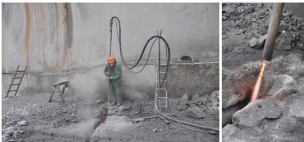
Rys. 13. Wykonywanie wciniek: a) palnikiem termicznie, b) cięciem piłą diamentową (fot. M. Stefanicka)
