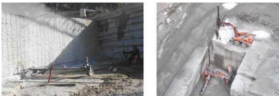
Rys. 9. Wiercenie otworów: a) poziomym perforatorem pneumatycznym, b) wiertnicami hydraulicznymi: Commando 120H – otwory pionowe; wiertnica Commando Liner DQ 100 – otwory poziome (fot. B. Korzeniowski)
