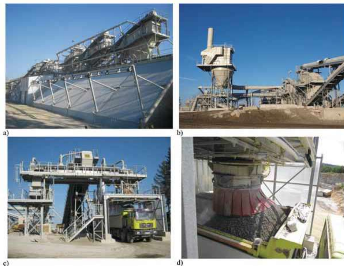
Rys. 8. Rozwiązania techniczne w Kopalni Wieśnica: a) hermetyzacja i odpylanie przesiewaczy oraz składowanie produktów w zamkniętych magazynach, b) centralna instalacja odpylająca zakładu przerobczego, c) zautomatyzowana wieża załadownicza z instalacją odpylającą i zraszającą, d) „teleskopowy” rękaw załadunkowy (fot. M. Stefanicka, T. Wojtaszek)
