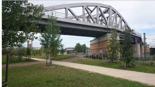
Ryc. 13. Most kolejowy nad parkiem Gleisdreieck . Źródło: ilustracje autorki
