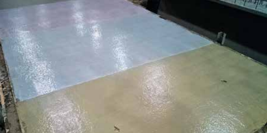
Fot. 1. Nanoszenie preparatu SIKA® Rugasol
