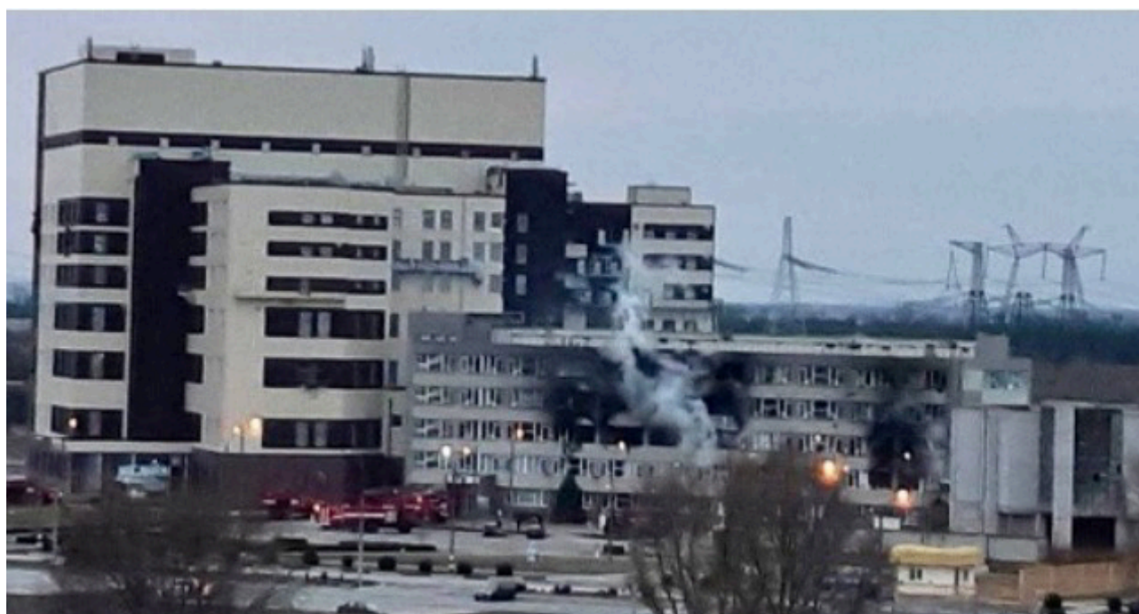
Fot. 2. Widok zniszczonego budynku administracyjnego na terenie EJ Zaporozże. (Pobrane z raportu IAEA o Ukrainie) Photo. 2. View of the destroyed administrative building on the premises of the Zaporozhye NPP. (Taken from the IAEA Ukraine report)
