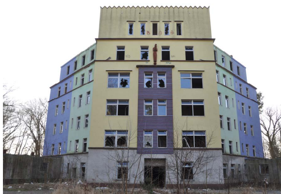
Rys. 3. Nowa Sól, dawny szpital powiatowy. Widok od północy na elewację frontową, stan obecny
