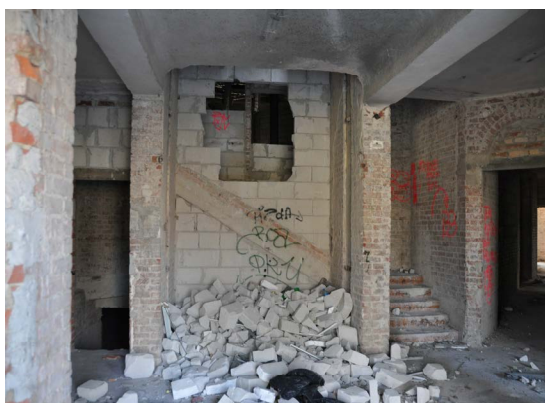
Rys. 7. Nowa Sól, dawny szpital powiatowy, hol przy wejściu głównym, stan obecny
