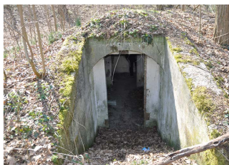
Rys. 10. Nowa Sól, dawny szpital powiatowy, schron na terenie parku
