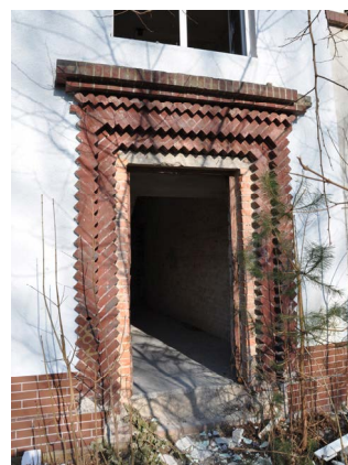
Rys. 6. Nowa Sól, dawny szpital powiatowy. Portal wejściowy w elewacji tylnej
