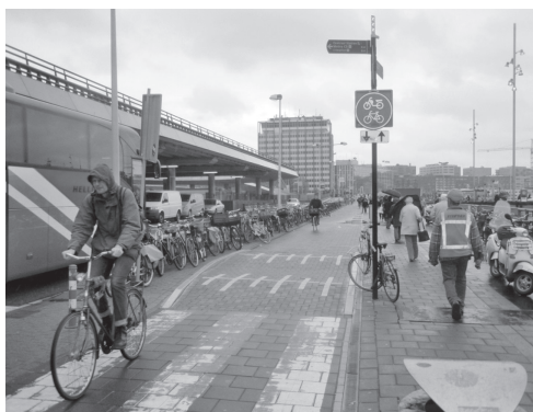
Fot. 6. Próg spowalniający na drodze rowerowej przed przejściem dla pieszych (Holandia)
