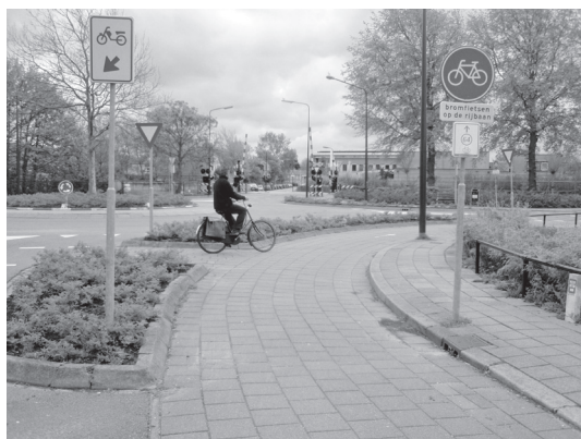
Fot. 21. Droga rowerowa z nawierzchnią z kostki betonowej, Holandia
