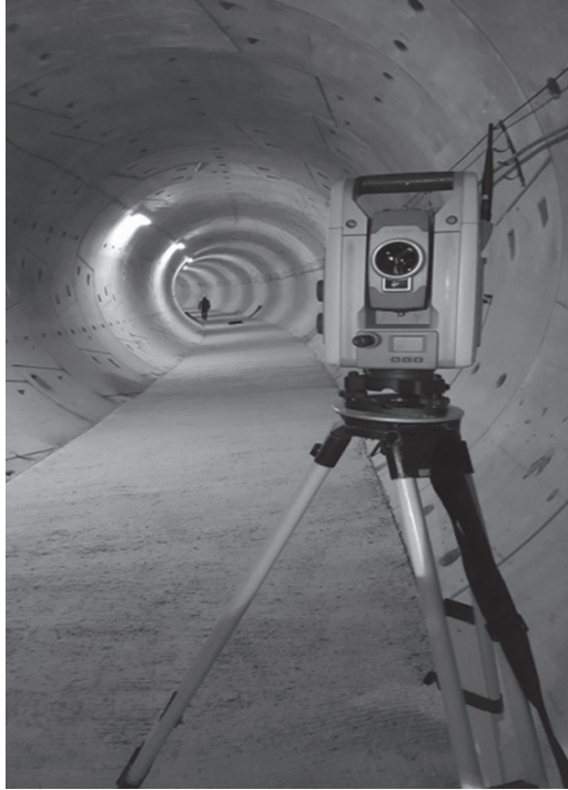
Rys. 3. Sferoidalna obudowa tunelu nr 1 duńskiego metra
