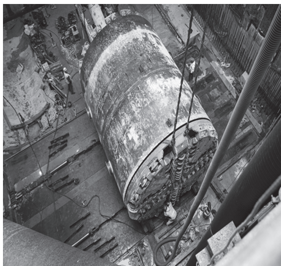
Rys. 2. Wprowadzanie maszyny TBM do tunelu
