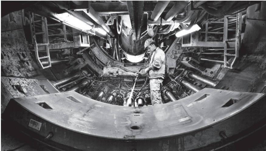
Rys. 4. Tubing przygotowany do montażu na budowie stacji AHM w Kopenhadze
