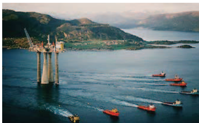
Rys. 2. Platforma Troll (wysokość 472 m) podczas transportu z fiordów na Morze Północne [1]
