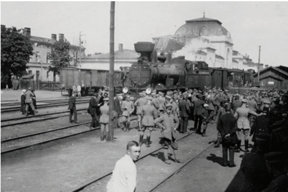
Fot. 12. Stacja Tarnów
