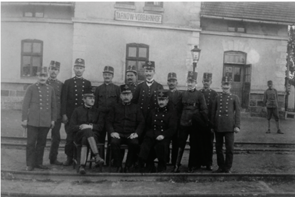
Fot. 1. Budynek zajazdowy stacji Tarnów Vorbanhof od strony torów kolejowych
