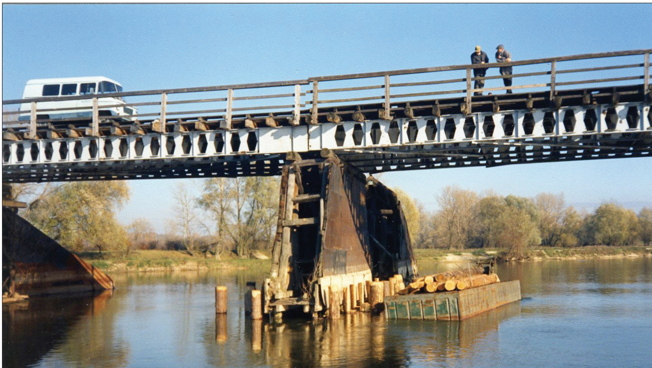
18. Stalowe spawane blachownice ażurowe Barzykowskiego na wyszogrodzkim moście. Źródło: fot. Wojciech Dąbrowski, GDDKiA 18. Barzykowski type steel welded plate girders of Wyszogród Bridge. Source: photo by Wojciech Dąbrowski, GDDKiA
