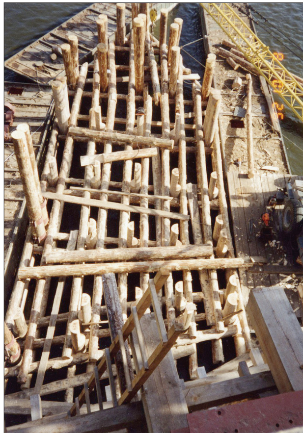
15. Prace nad odbudową drewnianej izbicy wyszogrodzkiego mostu. Źródło: Przedsiębiorstwo Budownictwa Lądowego Mazowieckie Mosty Sp. z o.o., fot. nieznan 15. The reconstruction work of wooden ice nose of Wyszogród Bridge. Source: Civil Construction Enterprise Mazowieckie Mosty Ltd., photographer unknown
