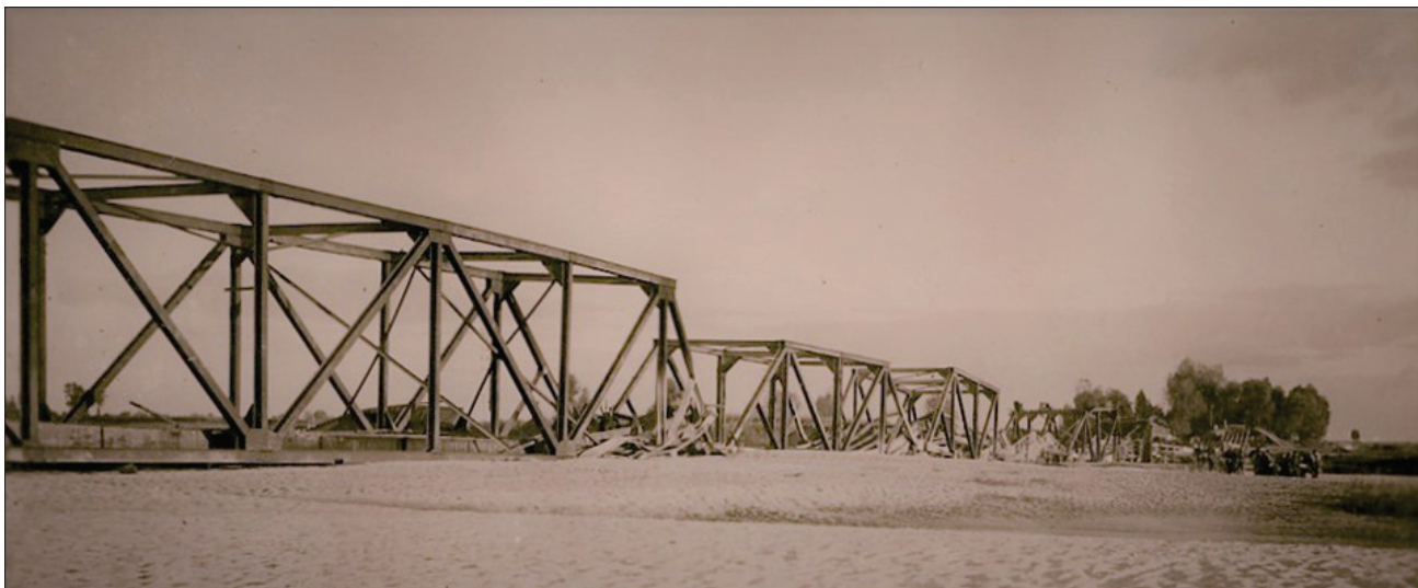
10. Stalowe kratownice Warrena ze słupkami z wyszogrodzkiego mostu we wrześniu 1939 r. Źródło: zbiory autora 10. Steel Warren through trusses with verticals from Wyszogród Bridge in September 1939. Source: author's collection
