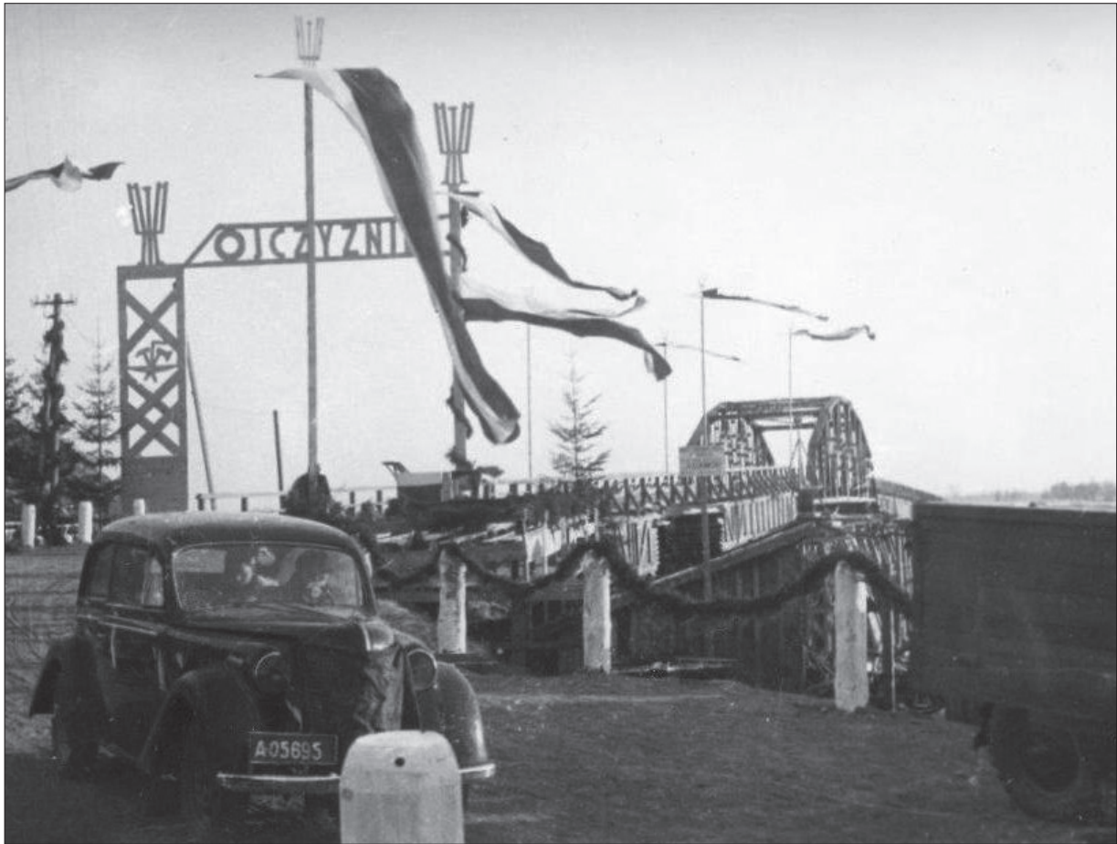
6. Brama triumfalna zbudowana na uroczystość oddania w użytkowanie odbudowanego mostu przez Wisłę w Wyszogrodzie, 16 grudnia 1946 r. Źródło: PORR Polska Infrastruktura SA, fot. nieznanym
