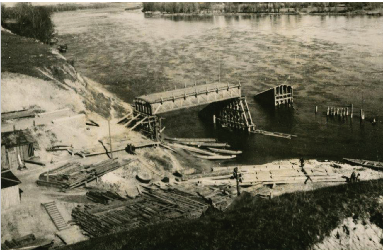
5. Fotografia mostu zniszczonego przez Niemców wykonana od strony Wyszogrodu dla „II Rejonowego Kierownictwa Odbudowy Mostów Drogowych”. Źródło: PORR Polska Infrastructure SA, fot. nieznanym
