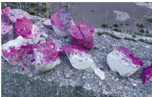
Rys. 6. Badania karbonatyzacji betonu
