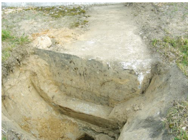
Rys. 2. Odkrywka płyty fundamentu nr 7
