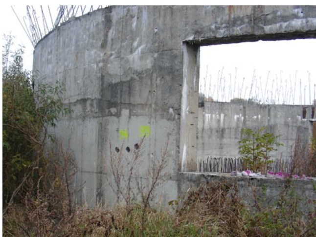
Rys. 3. Fragment fundamentu nr 6; po lewej wąski fragment fundamentu nr 7
