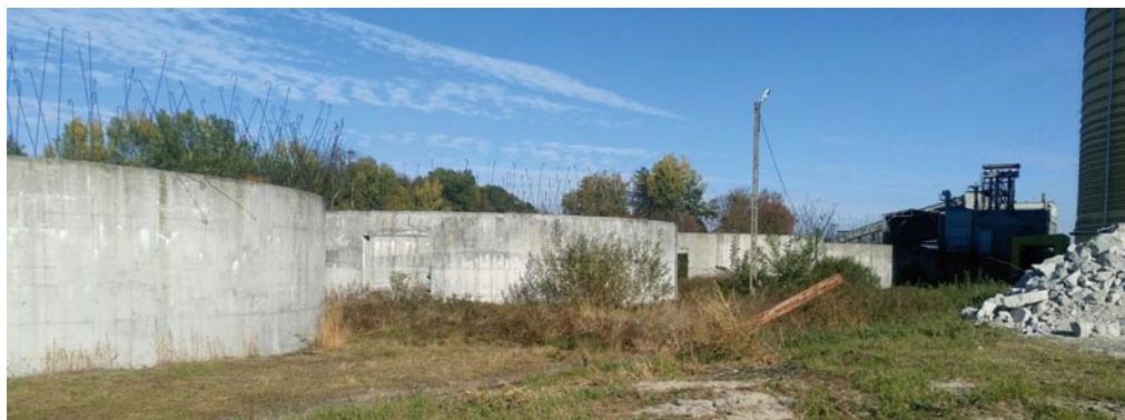
Rys. 1. Widok ogólny fundamentów pod silosy od strony południowej
