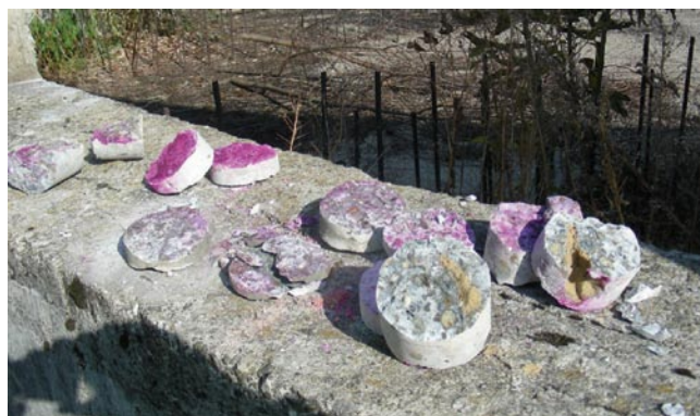
Rys. 4. Rozwarstwione (uderzeniami o beton) próbki-odwieroty; po prawej: próbka ze żle wymieszanych składników betonu – wewnątrz widoczne kruszywo (piasek)
