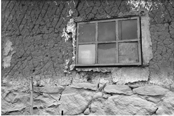
Ryc. 6. Drugi z glinoziemnych budynków gospodarczych we wsi Żyrwiny – oryginalna faktura ściany; fot. J. Lutyńska, 2015 Fig. 6. The second earthen barn in Żyrwiny – an original wall structure; photo by J. Lutyńska, 2015
