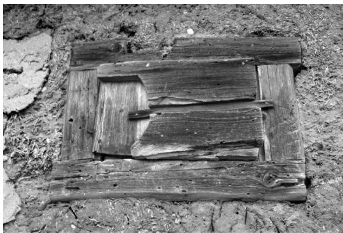
Ryc. 22. Okienko w ścianie budynku gospodarczego w osadzie Jasionowo; fot. J. Lutyńska, 2015
