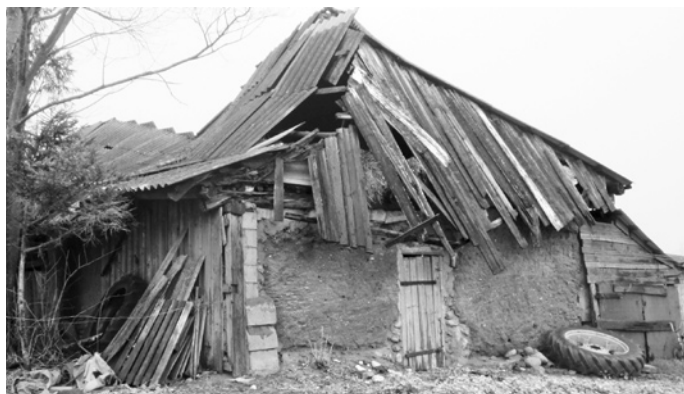
Ryc. 19. Budynek gospodarczy Krzysztofa Augustynkowicza w osadzie Węgielnia; fot. J. Lutyńska, 2015
