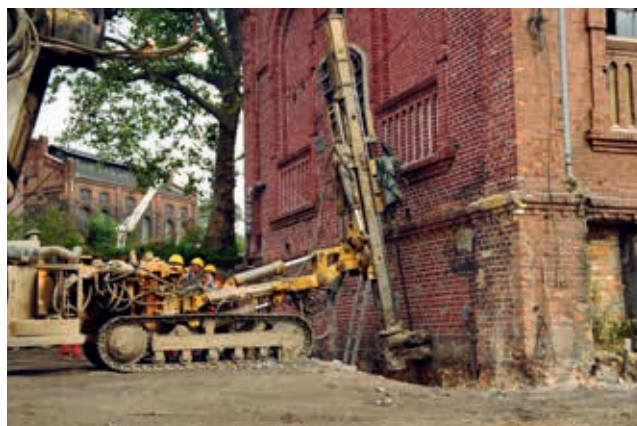
Wzmocnienie fundamentów byłej maszynowni szybu „Warszawa” MS-8 na budowie Nowego Muzeum Śląskiego w Katowicach za pomocą mikropali iniekcyjnych TITAN, fot. TITAN Sp. z o.o.
