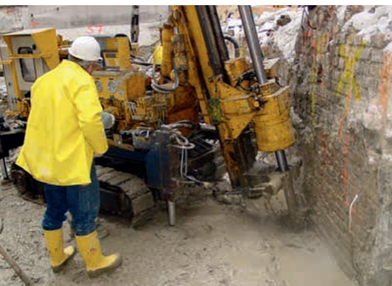
Iniekcja na budowie hotelu Polonia w Warszawie, fot. Keller Polska Sp. z o.o.
