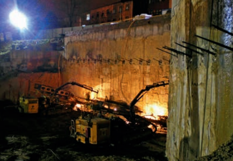
Budowa kompleksu sportowego Akademii Rolniczej w Lublinie, fot. Hydrobudowa-Stump Sp. z o.o.
