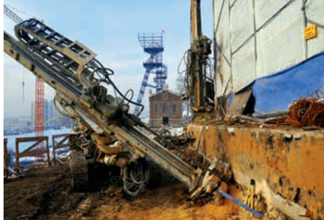
Wzmocnienie fundamentów dawnego magazynu odzieżowego MS-15 na budowie Nowego Muzeum Śląskiego w Katowicach za pomocą mikropali iniekcyjnych TITAN, fot. TITAN Sp. z o.o.
