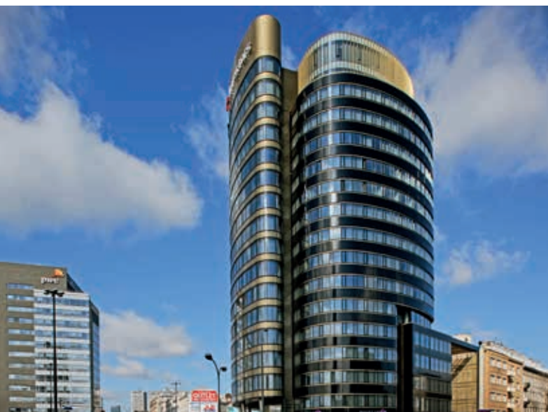
Zebra Tower, Warszawa, fot. Bilfinger Infrastructure SA
