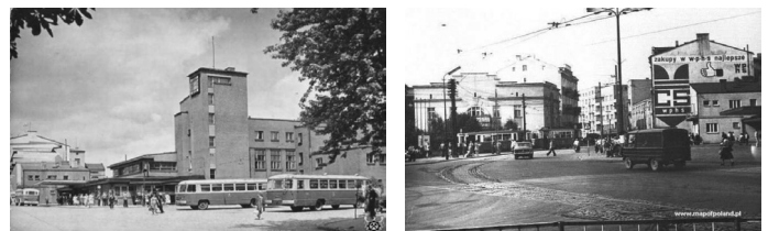
Rys. 3. Skrzyżowanie ulic Modrzejewskiej i Małachowskiego przed dworcem kolejowym w Będzinie w okresie powojennym
