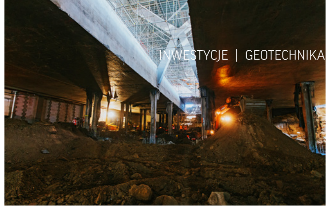
Wykop podstropowy w segmencie 5, przebudowa stacji Warszawa Zachodnia
