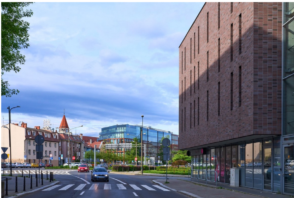
Fot. 12. Parking wielopoziomowy w obiekcie zbudowanym w przestrzeni półprywatnej – (Gliwice, ul. Dunikowskie-go – maj 2024) – ogólnodostępny parking o funkcji park@go dla obsługi Starego Miasta, a możliwy do uzyskania efekt został ograniczony przez małą pojemność parkingową obiektu (zdjęcie autora).
