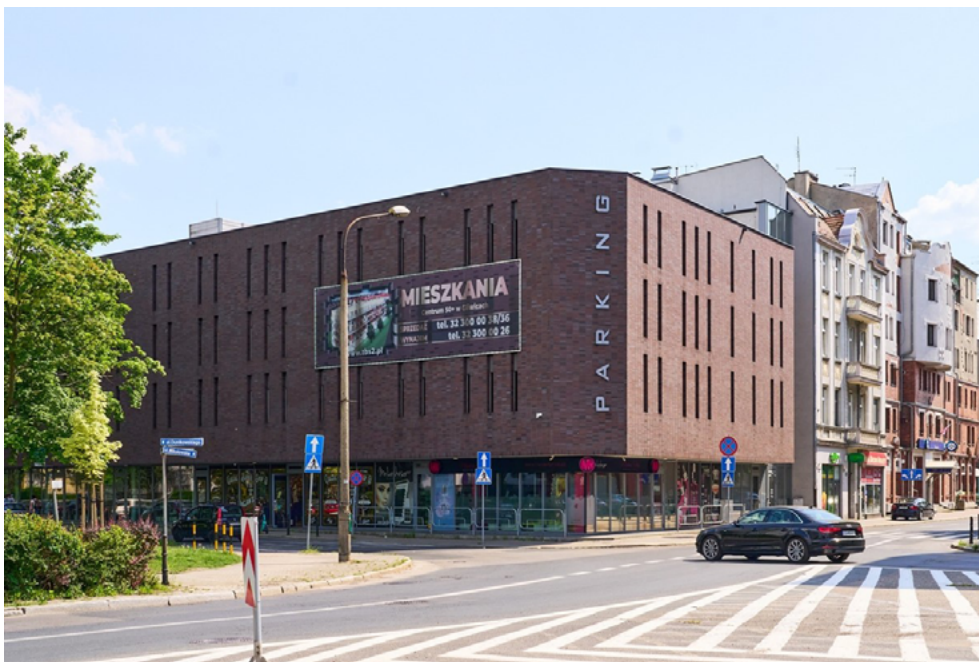
Fot.5. Parkowanie w publicznych przestrzeniach w obiektach zbudowanych - parkowanie w układzie wielopoziomowym, w parkingu TBS - dominacja funkcji parkingowej (Gliwice, ul. Dunikowskiego - maj 2024) - wprowadzenie parkowania na kilku poziomach redukuje obszar zawłaszczanej przestrzeni półprywatnej (zdjęcie autora)
