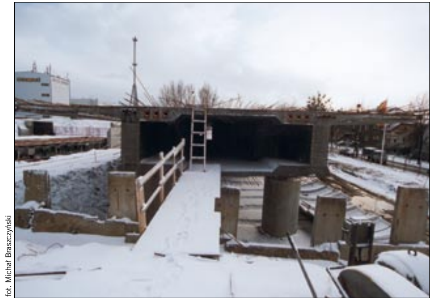
Jedyna dopuszczalna wysokość ustroju nośnego narzuca kształt przekroju poprzecznego konstrukcji – przekrój skrzyniowy
