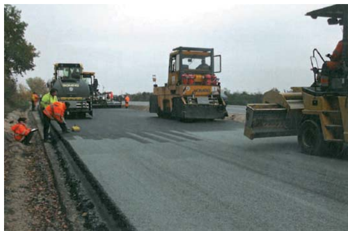
Fot. 3. Wbudowywanie mieszank mineralno-asfaltowych przy zastosowaniu rozkładarki, dwóch walców ogumionych oraz rozsypywarki liniowej w celu wytworzenia warstwy rozdzielającej
