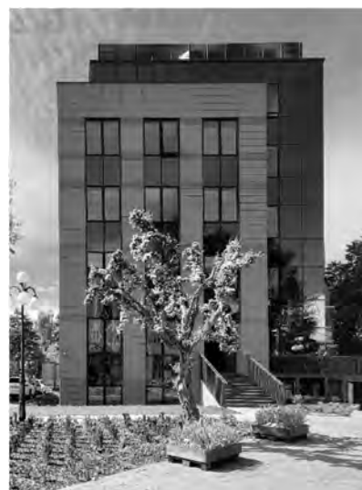
Rys. 7. Budynki w których mieści się baza laboratoryjno-dydaktyczna: a) budynek B1, dziekanat Wydziału, b) budynek C3-C2, c) budynek D2
