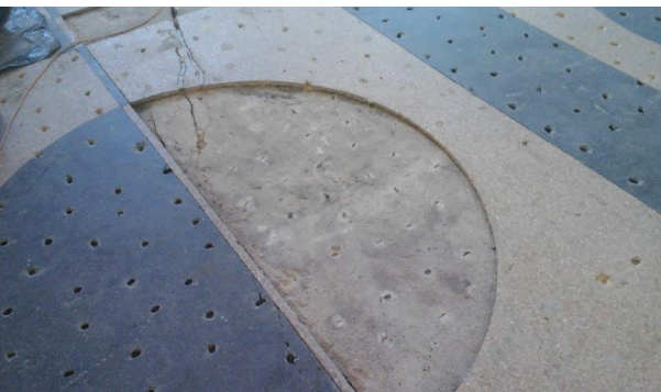
Fot. 4. Naprawa rys konstrukcyjnych i uzupełnianie ubytków [M1]
