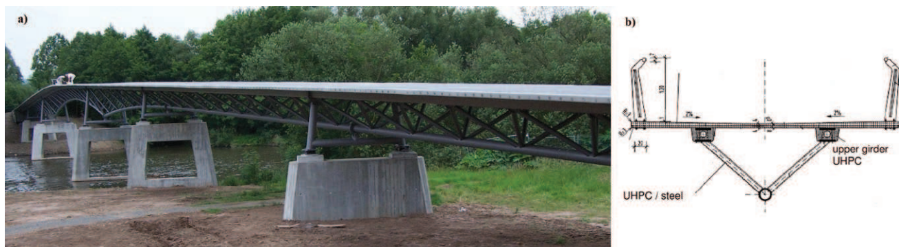
Rys. 3. Most Gärtnerplatz w miejscowości Kassel w Niemczech [19]: a) widok, b) przekrój poprzeczny przęsła
