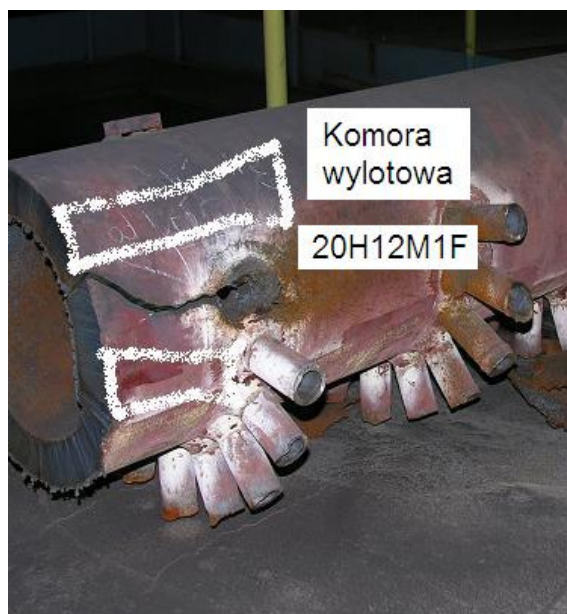
Rys. 4. Elementy instalacji, z których pobrano próbki do badań
