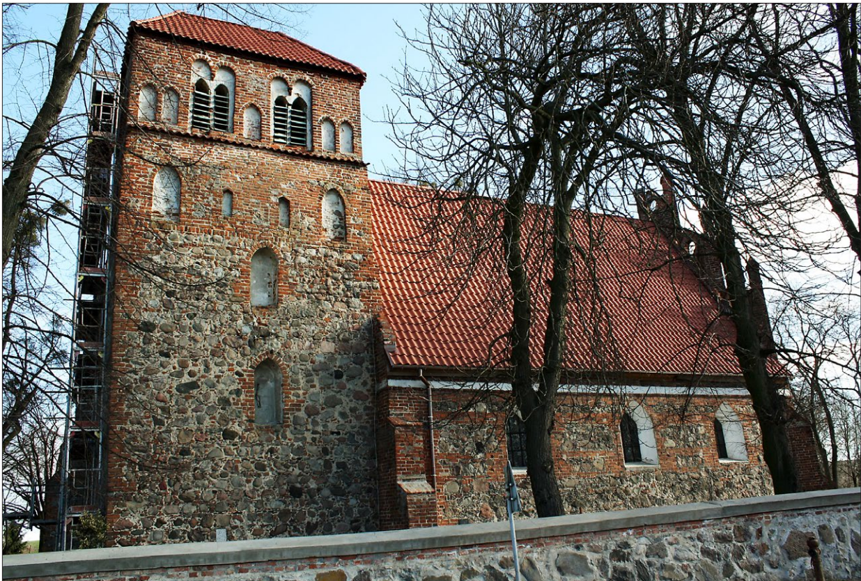
Ryc. 4. Widok od strony południowej na wieżę; fot. M. Prarat 2019. Fig. 4. View of the tower from the south; photo by M. Prarat 2019.
