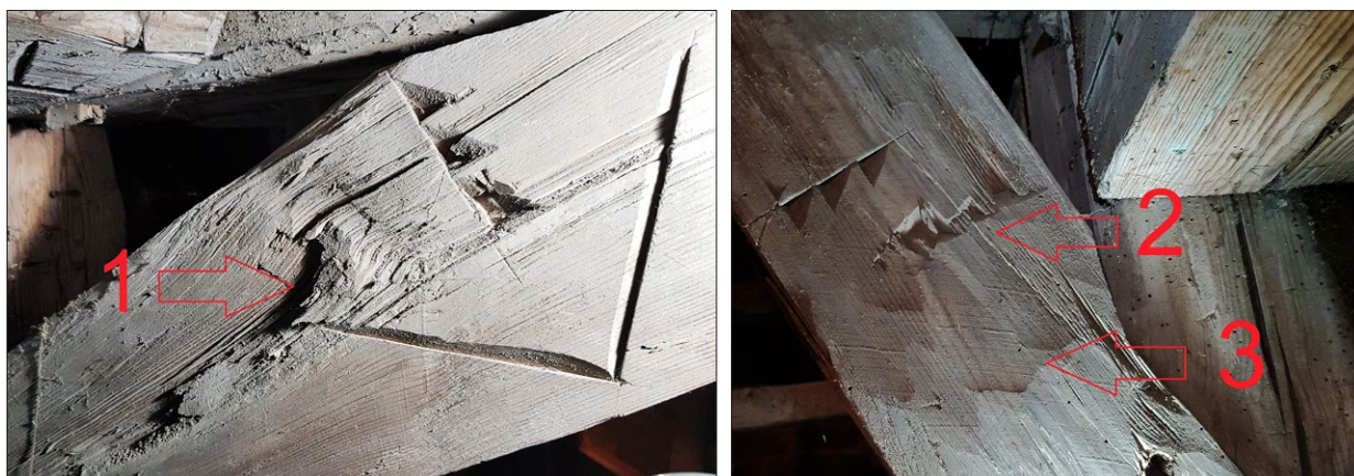
Ryc. 10. Fragment konstrukcji więźby dachowej: a) zastrzał ramy storczykowej, b) zastrzał wiązara; oznaczenia: 1 – ślad po rozłupaniu, 2 – ślad po uderzeniu siekierą, 3 – ślad po wyrównaniu budulca toporem; fot. M. Prarat 2019.
