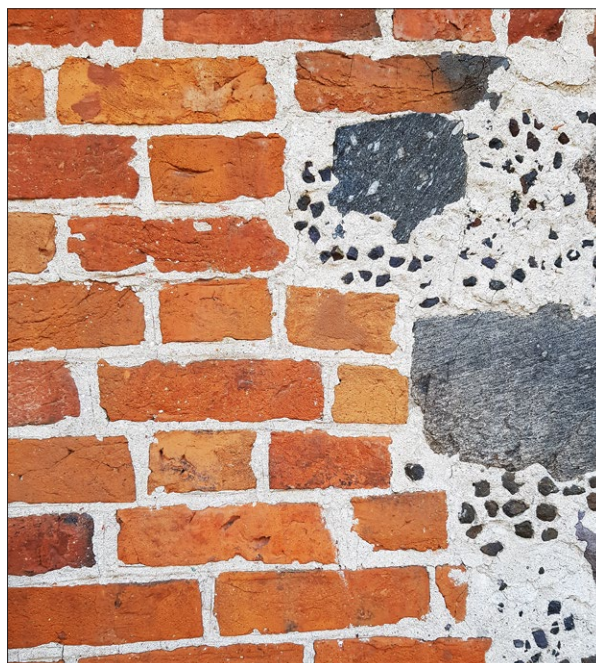
Ryc. 9. Fragment elewacji nawy; widoczne uzupełnienie ściany kamiennej okrzeskami, spoina pomiędzy warstwami cegieł opracowana poprzez dwustronne podcięcie w poziomie i kreskę w pionie; fot. M. Prarat 2019.
