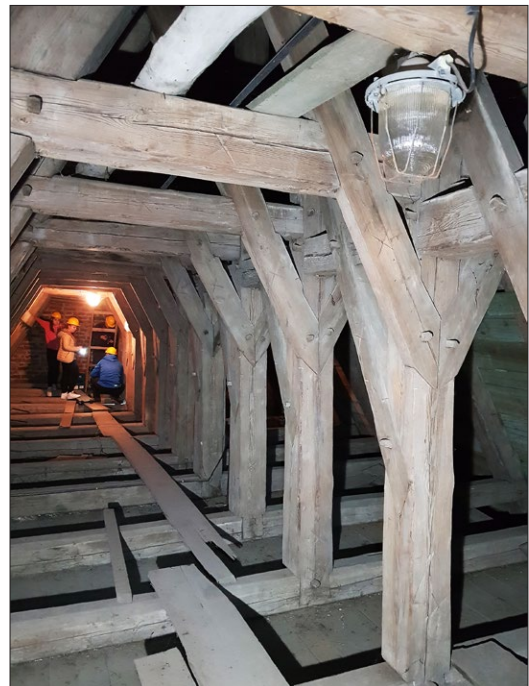
Ryc. 7. Wieżba storczykowa niezredukowana, po 1450 (d); oznaczenia: a – widok więzara od strony odwiązania, b – widok na ramę storczykową; fot. M. Prarat 2019.
