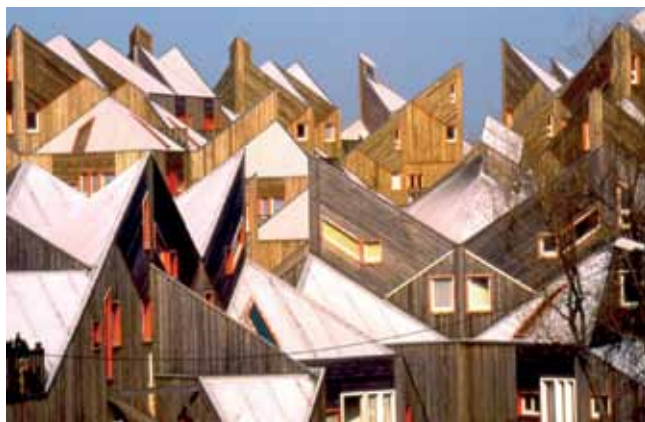
Rys. 1. Czworosciany zwieńczające budynki, osiedle mieszkalne La Pièce Pointue, Le Blanc-Mesnil, Francja
