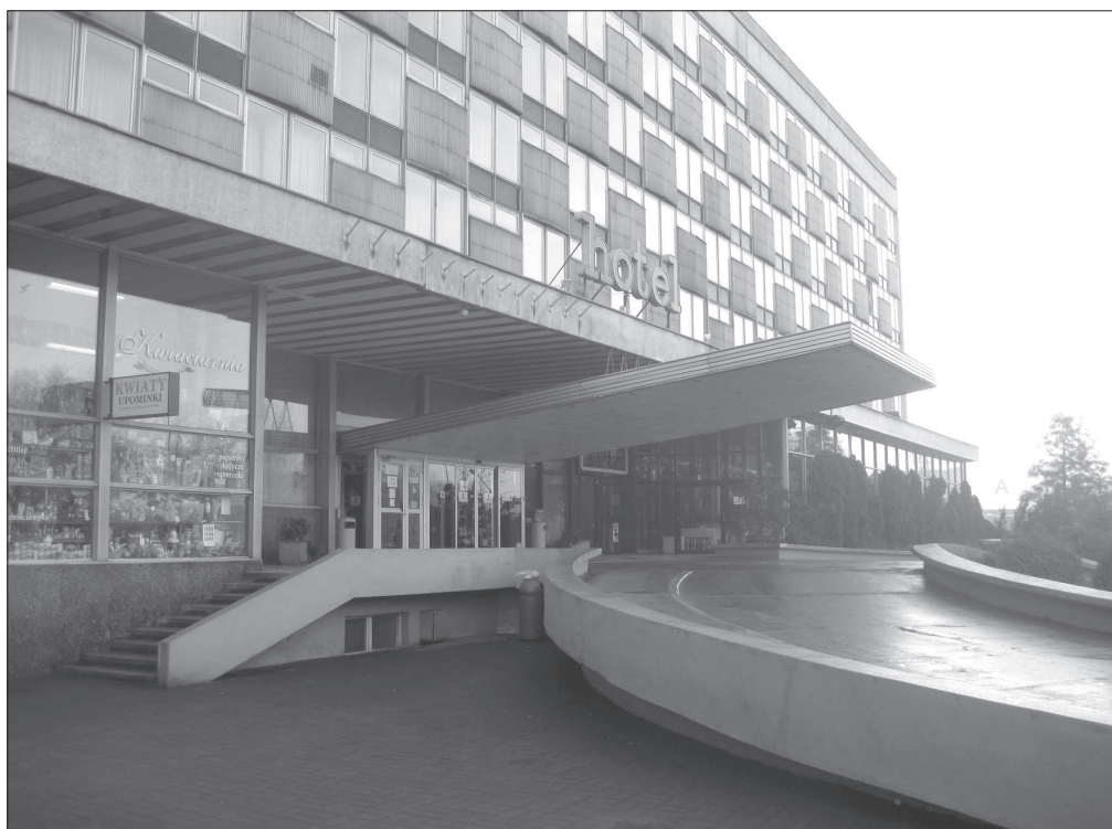
6. Zespół hotelu „Cracovia” i kina „Kijów” w Krakowie, proj. Witold Cęckiewicz, fot. M. Włodarczyk, 2012
