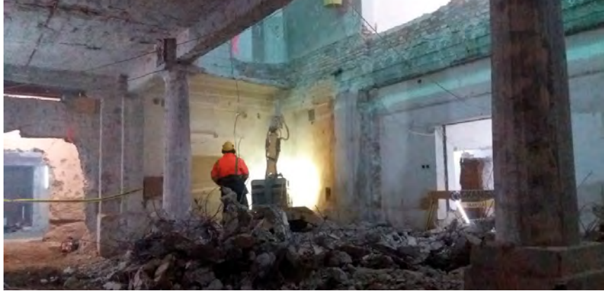
Fot. 1. Rozbiórka płyty stropowej przy użyciu maszyny ze zdalnie sterowanym ramieniem, na którym zamocowane jest urządzenie udarowe
