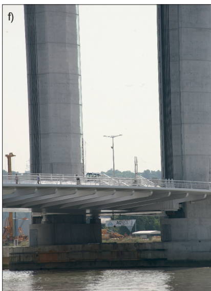
Fot. 5. Most Chaban Delmasa: a) widok całości, b) przęsło przed uniesieniem, c) przęsło uniesione maksymalnie, d) podpora w nurcie rzeki, e) most „do nikąd”, f) wieże do podnoszenia przęsła, g) zbocza linowe u szczytu wież
