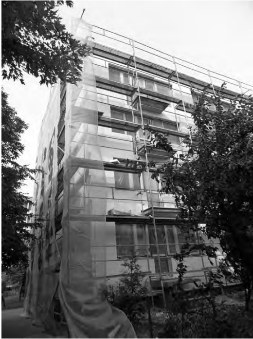
Rysunek 2.6. Fragmentu budynku przy ulicy Spółdzielczej 30 w Łomży
