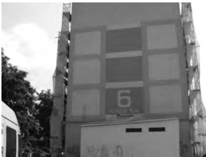
Rysunek 2.13. Fragment budynku wielkopłytkowego na ul. Kołłątaja 6 w Łomży
