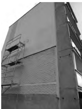
Rysunek 2.8. Ściana szczytowa budynku przy ulicy Prusa 4 w Łomży
