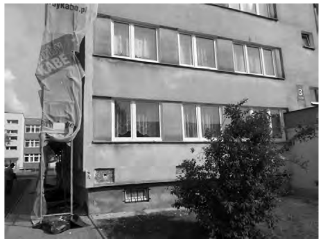
Rysunek 2.4. Fragmentu budynku przy ulicy Chopina 3 w Łomży
