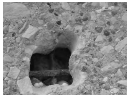
Rysunek 3.3. Widok odkrywek siatki zbrojeniowej w warstwie fakturowej
