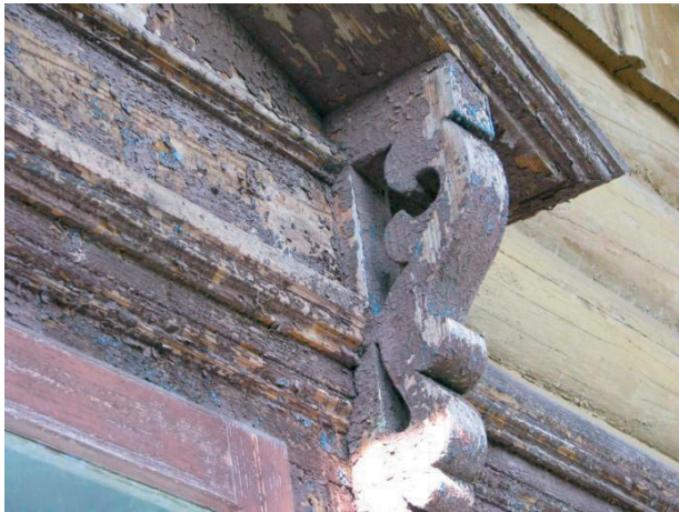
Fot. 17. Detal drewniany malowany farbą ftalową. Pałac w Julinie, 2014, fot. K. Wieczorek
