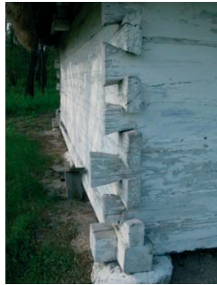
Fot. 2. Narożnik domu z drewna piłowanego, ze środka przekroju pnia (widoczny rdzeń), Sucha, skansen
