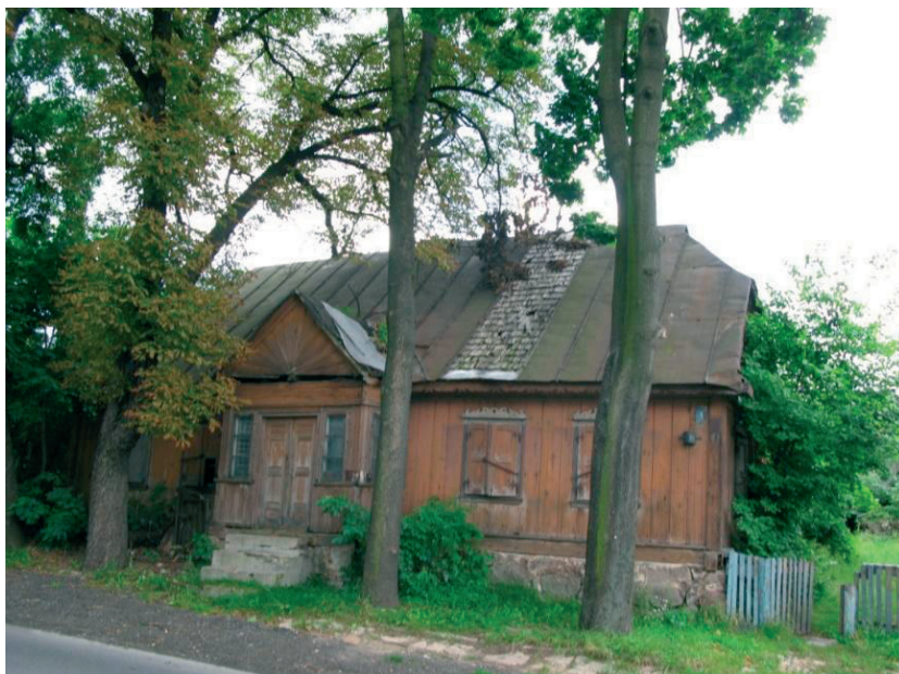
Fot. 3. Pokrycie dachu z wióra osikowego przesłonięte pokryciem z blachy. Sokółów Podlaski 2011, fot. K. Wieczorek
