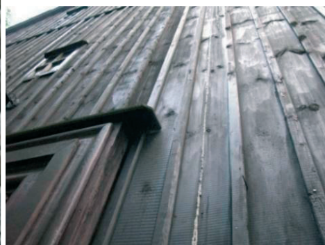
Fot. 15. Szalunek drewniany strugany maszynowo. Gąsawa, kościół z XVII w., fot. K. Wieczorek
