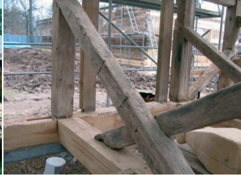
Fot. 13. Ślady po obróbce okrągłaka toporem. Ciechanowiec, dzwonnica z Bogut., 2010, fot. K. Wieczorek
