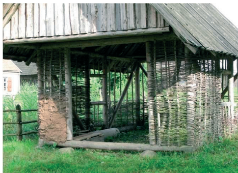
Fot. 5. Konstrukcja plecionkowa (kosznicowa), połączona ze słupowo-ryglową, Rumszyski, Skansen, fot. K. Wieczorek
