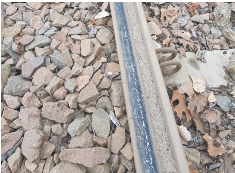
Ryc. 25. Mada na główce szyny, utrudniająca hamowanie.
