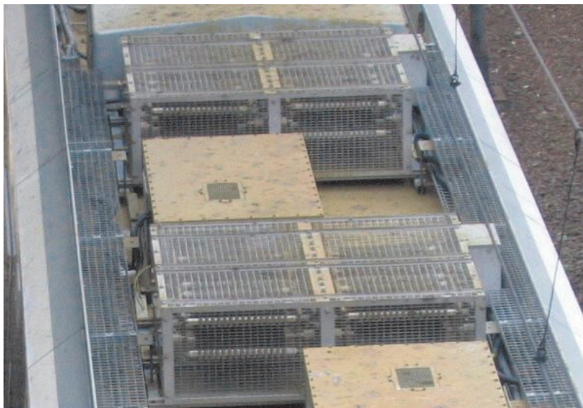
Ryc. 13. Kontenery z opornikami hamowania na dachu pojazdu.
