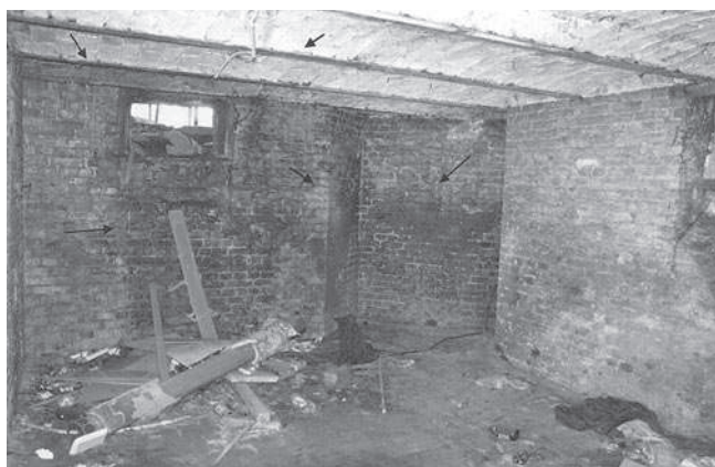
Rys. 3. Jedno z pomieszczeń piwnicznych
