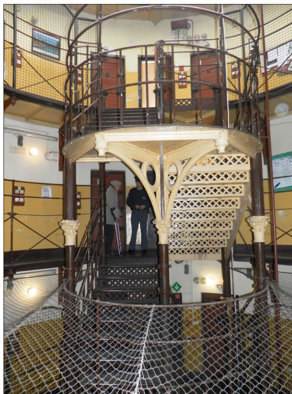
Ryc. 7. Schody żeliwne, widok na wszystkie elementy składowe – konstrukcja i dekoracja; plan pierwszy: kolumny stanowiące wsparcie dla policzków schodowych, w tym środkowa dodatkowo podtrzymująca podest międzypiętrowy; plan drugi: łączenie się schodów z galeriami pięter; fot. Ł. Lewandowski 2015.
