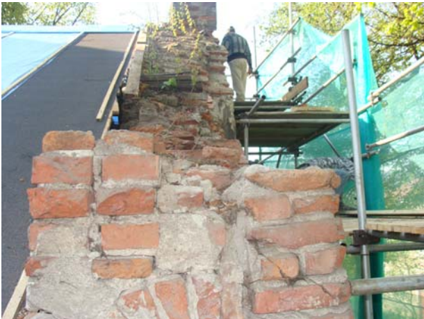
Ryc. 3. Cerkiew w Baligrodzie – korona murów – maj 2009 r. (fot. J. Kufel) Fig. 3 The Orthodox Church in Baligród – wall crests – May 2009 (photo J. Kufel)
