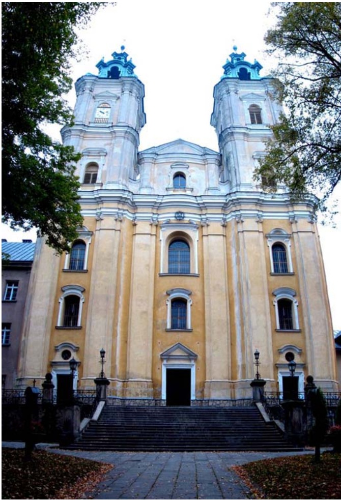
Ryc. 7. Sanktuarium w Starej Wsi – elewacja frontowa – 2008 r. (fot. inż. J. Siwek) Fig. 7. The Sanctuary in Stara Wieś – front façade – 2008. (photo J. Siwek)
