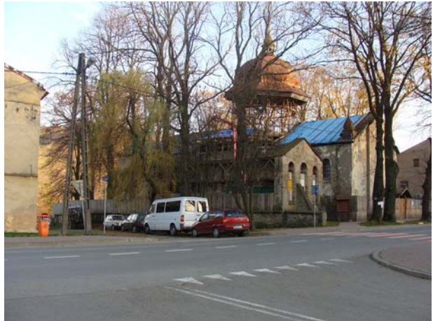
Ryc. 2. Cerkiew w Baligrodzie w trakcie remontu dachu i kopuły – listopad 2008 r. (fot. Stowarzyszenie Ratowania Cerkwi w Baligrodzie) Fig. 2 The Orthodox Church in Baligród during the restoration of its roof and dome – November 2008 (photo Save the Orthodox Church in Baligród Association)
