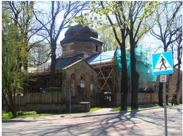
Ryc. 4. Cerkiew w Baligrodzie – zrekonstruowana więźba dachowa – kwiecień 2009 r. (fot. J. Kufel) Fig. 4. The Orthodox Church in Baligród – reconstructed roof structure – April 2009 (photo J. Kufel)
