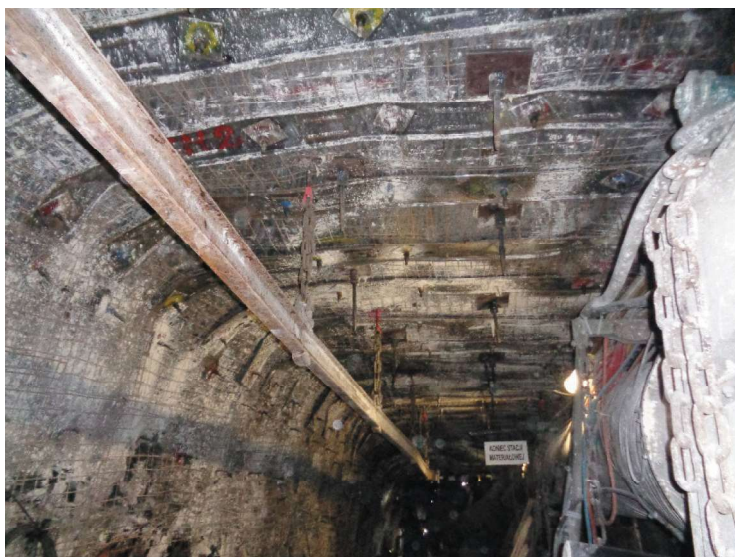
odwiercenie otworu oraz zabudowa kotwi z naciągiem wstępnym na strop ~200 kN
