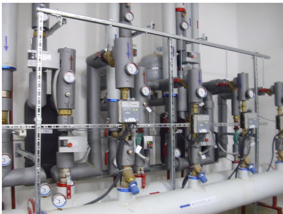
Rys. 5. Fragment systemu zasilania w ciepło/chłód 11 central nawiewnych
