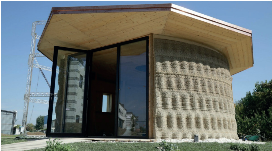
Rys. 3. Gaia – pierwszy dom wydrukowany w 3D z użyciem gleby jako materiału. © WASP
